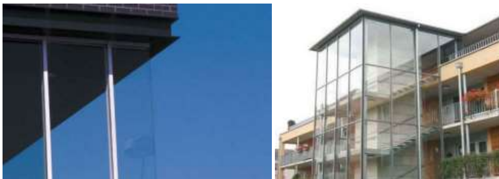
Figura 4-4: Edificio con pareti angolari trasparenti (a sinistra) e torre in vetro per ascensore (a destra) (Fonte: Schmid H., Doppler W., Heynen D., Rössler M., 2013)
